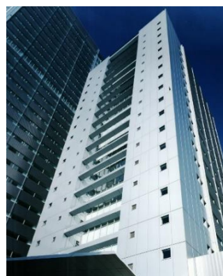
中野坂上セントラルビル
